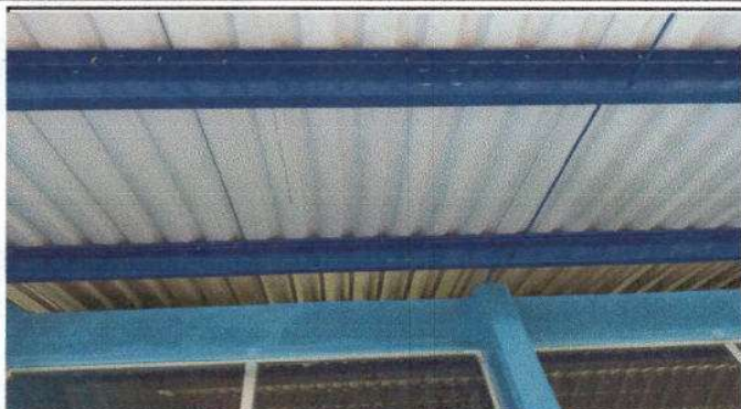
Foto1: Sustitucion de Lamina
