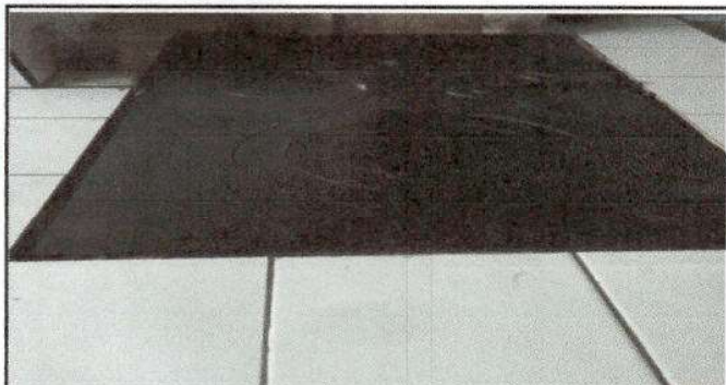
Foto 3: Cambio de Plancha y azulejo
